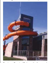
Centrum Sportu i Rekreacji - Aquapark w Wielkiej Nieszawce (Polka)
